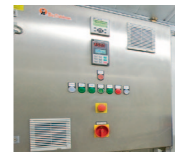
Индивидуально планируемый распределительный шкаф
